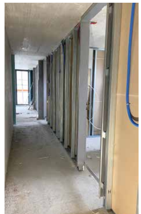
Ständerkonstruktion der Innenwände
